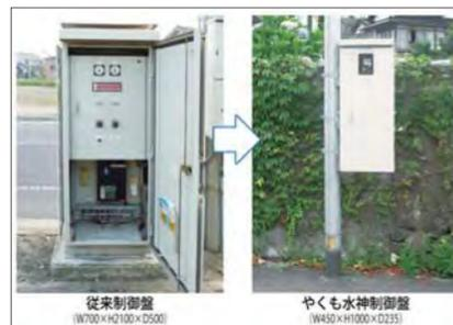
従来制御盤とやくも制御盤の比較写真
