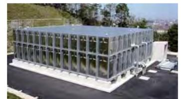
ボルト組立式ステンレス製貯水槽
